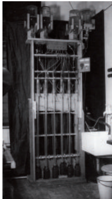
Appareil semi-automatique réalisé par N.G.HEATLEY pour la purification de la pénicilline
